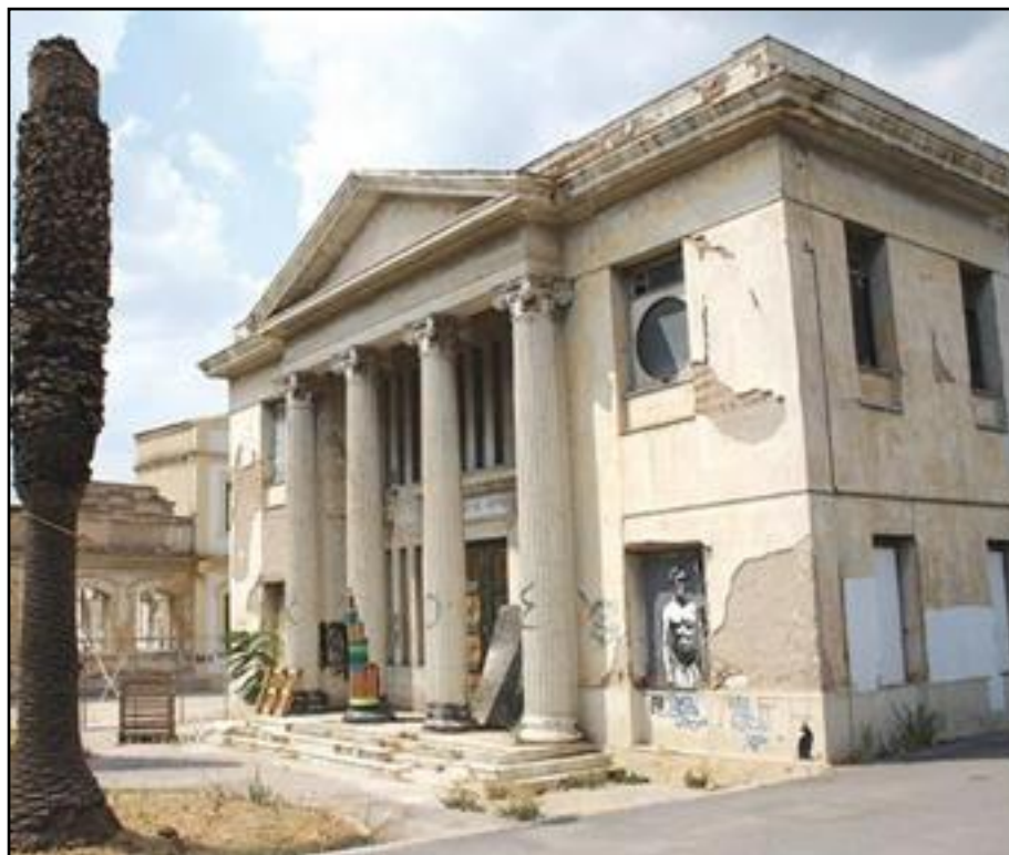
Οι εργασίες αποκατάστασης της Σχολής Ωραίων Τεχνών
